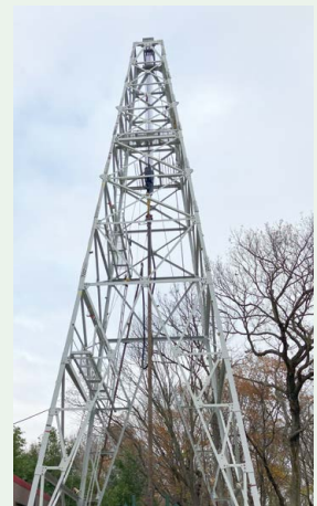
温泉掘削現場
