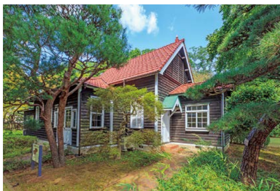
中村彝アトリエ外観
